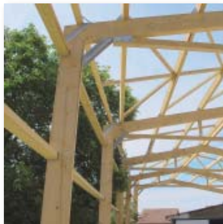
✓ Portique en bois massif avec assemblages en bois reconstitué
